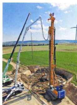
Eines der größten verfügbaren Großdrehbohrgeräte im Einsatz: die Bauer BG45
